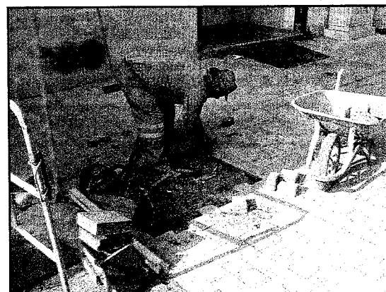
Cette semaine, la société Sobeca d'Herblay (Val d'Oise) effectue des travaux rue Louvet, entre les places des Halles et Jeanne-Hachette. Suite au renouvellement du réseau basse tension, qui a également concerné la rue Jacoby, des pavés sont remis en place.
