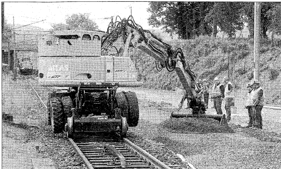
À Saint-Sulpice, la SNCF a renouvelé 350 mètres de voie très endommagée.
